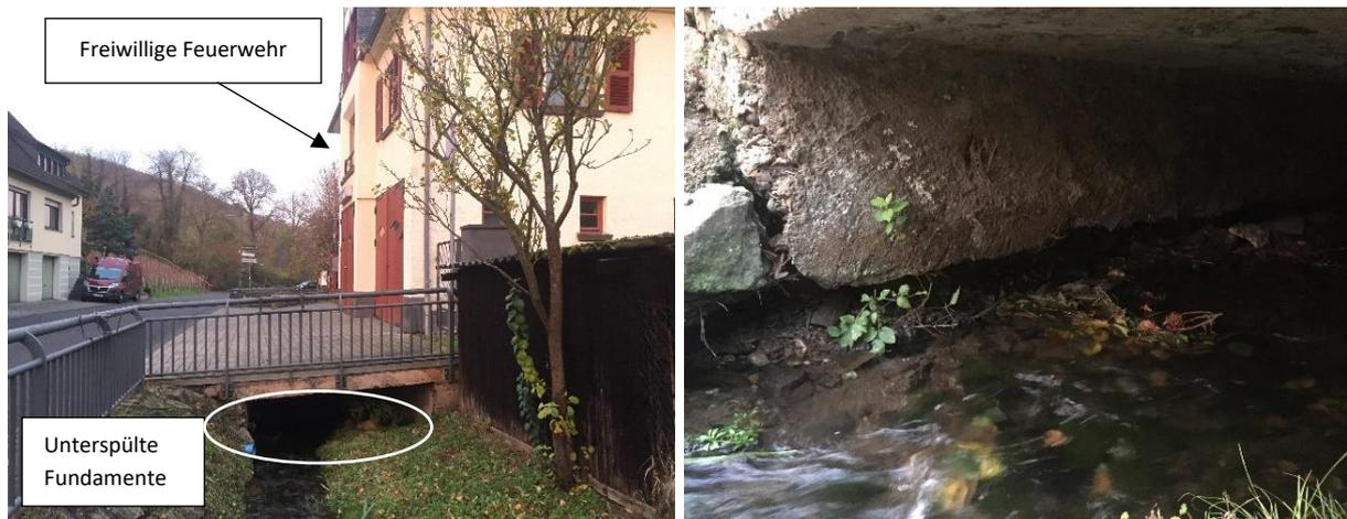
Abbildung 34: Brücke über Waschgraben vor der Feuerwehr (links) mit unterspülten Fundamenten
