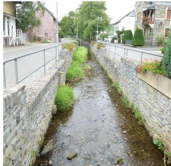
Abbildung 16: Übersicht der Situation an der Brücke Nr. 1 und generelle Struktur des Frohnbaches mit stellenweise tiefen Einschnitten der Ufermauer
