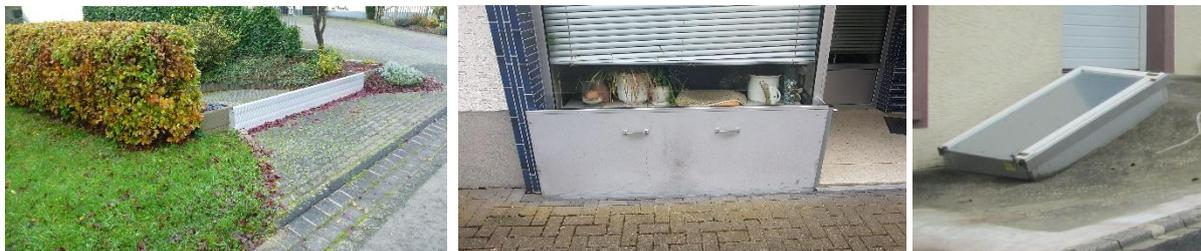
Abbildung 28: Beispiele von Objektschutzmaßnahmen (mobile Steckelemente, Dammbalkensysteme, Abdichtungen)
