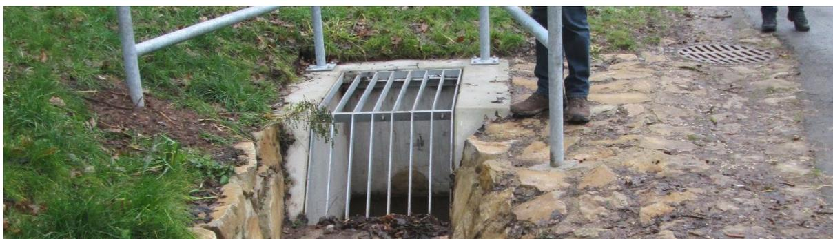
Abbildung 32: Beispiel eines mehrdimensional anströmbaren Einlaufgitters
