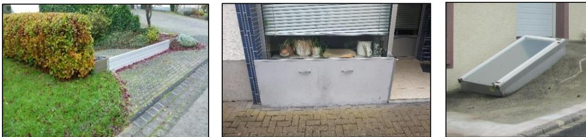
Abbildung 79: Beispiele von Objektschutzmaßnahmen (mobile Steckelemente, Dammbalkensysteme, Abdichtungen)
