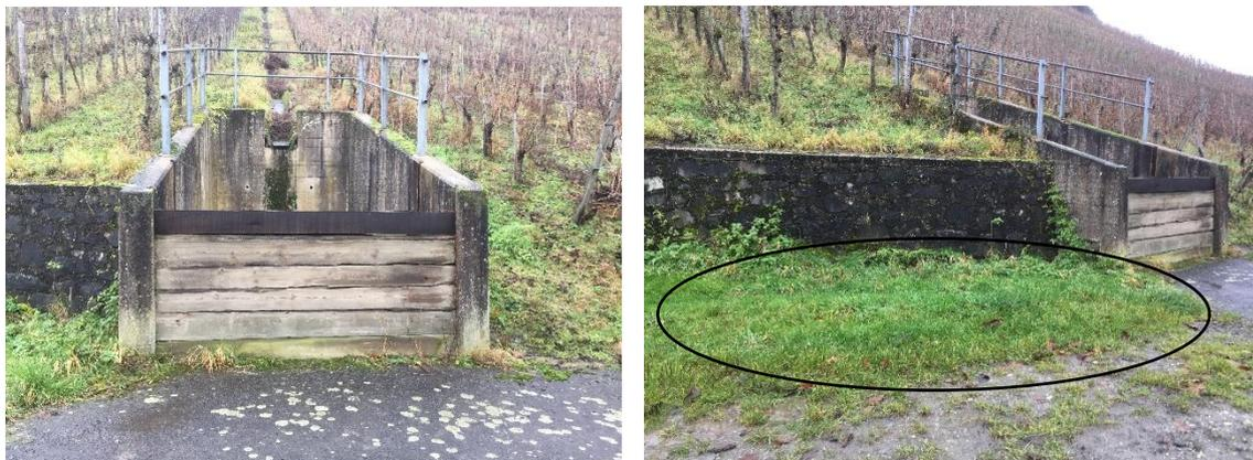
Abbildung 58: Regenrückhaltebecken in den Weinbergen mit Anlandungen
