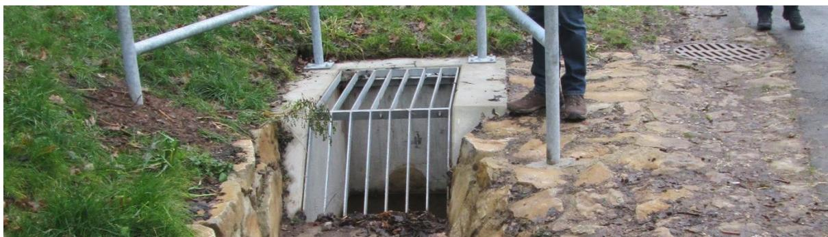
Abbildung 54: Beispiel eines dreidimensional anströmbaren Einlaufgitters
