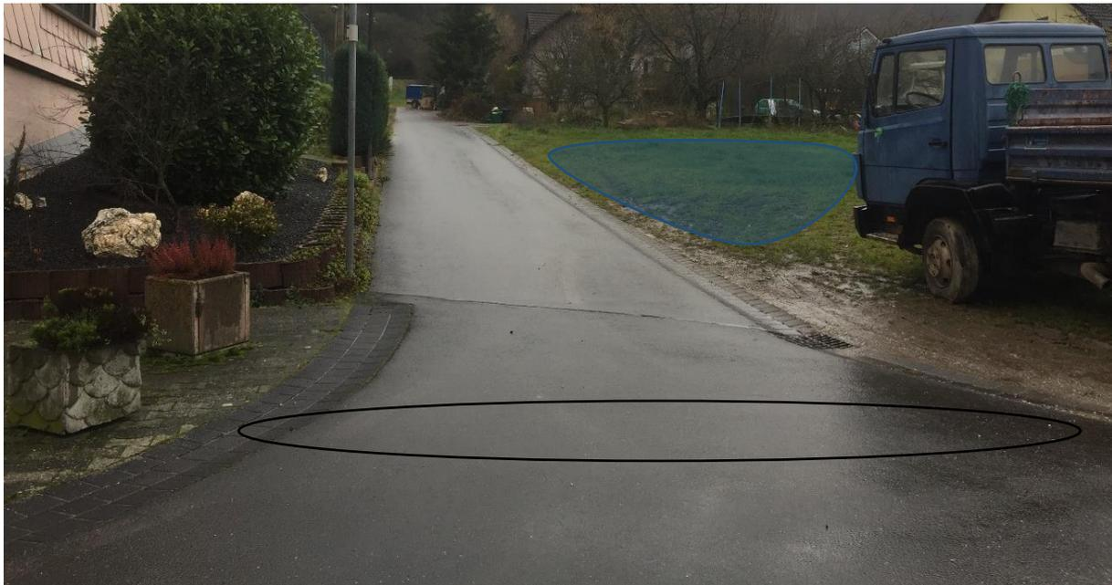
Abbildung 61: Mögliche Lage der Entwässerungsrinne und der Rasenmulde
