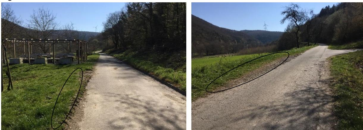
Abbildung 47: Bereich einer nötigen Erhöhung (links) und Absenkung (rechts) der Bankette
