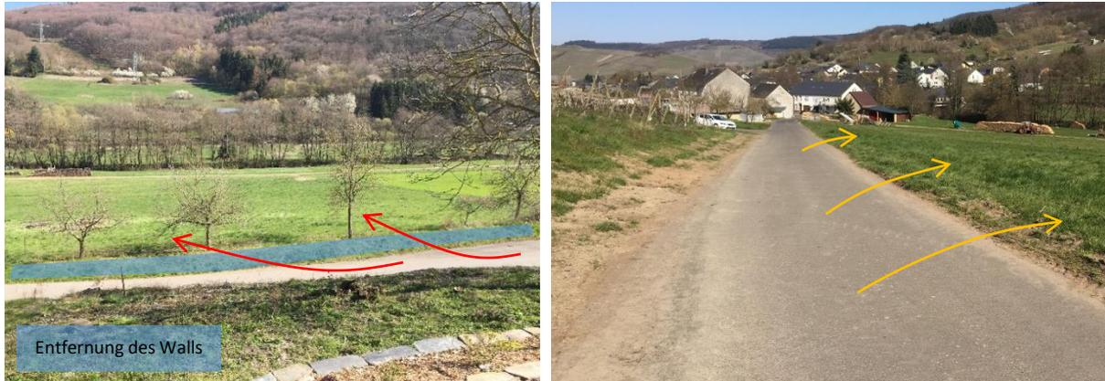
Abbildung 48: Entfernung der Wälle und Abschieben der Bankette zur Ableitung des Wassers
