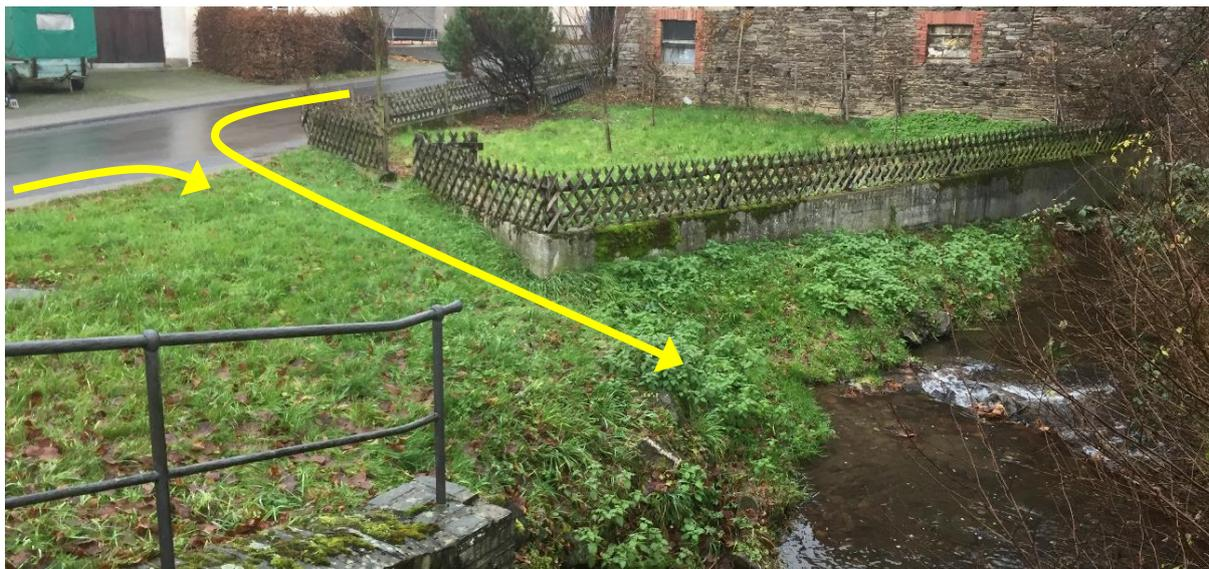
Abbildung 31: Fließrichtung entlang des notwendigen Notwasserweges
