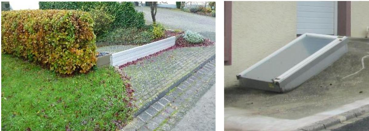
Abbildung 40: Beispiele von Objektschutzmaßnahmen (mobile Steckelemente, Abdichtungen)
