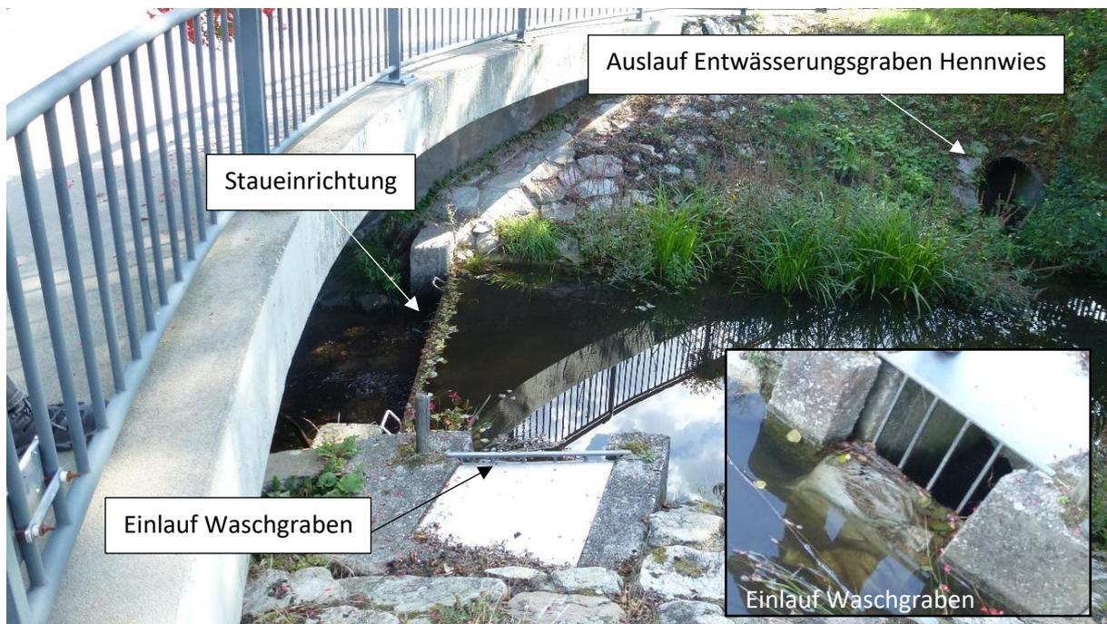
Abbildung 20: Situation an Brücke (Nr. 1) über Frohnbach mit Ein- und Auslässen und der Staueinrichtung
