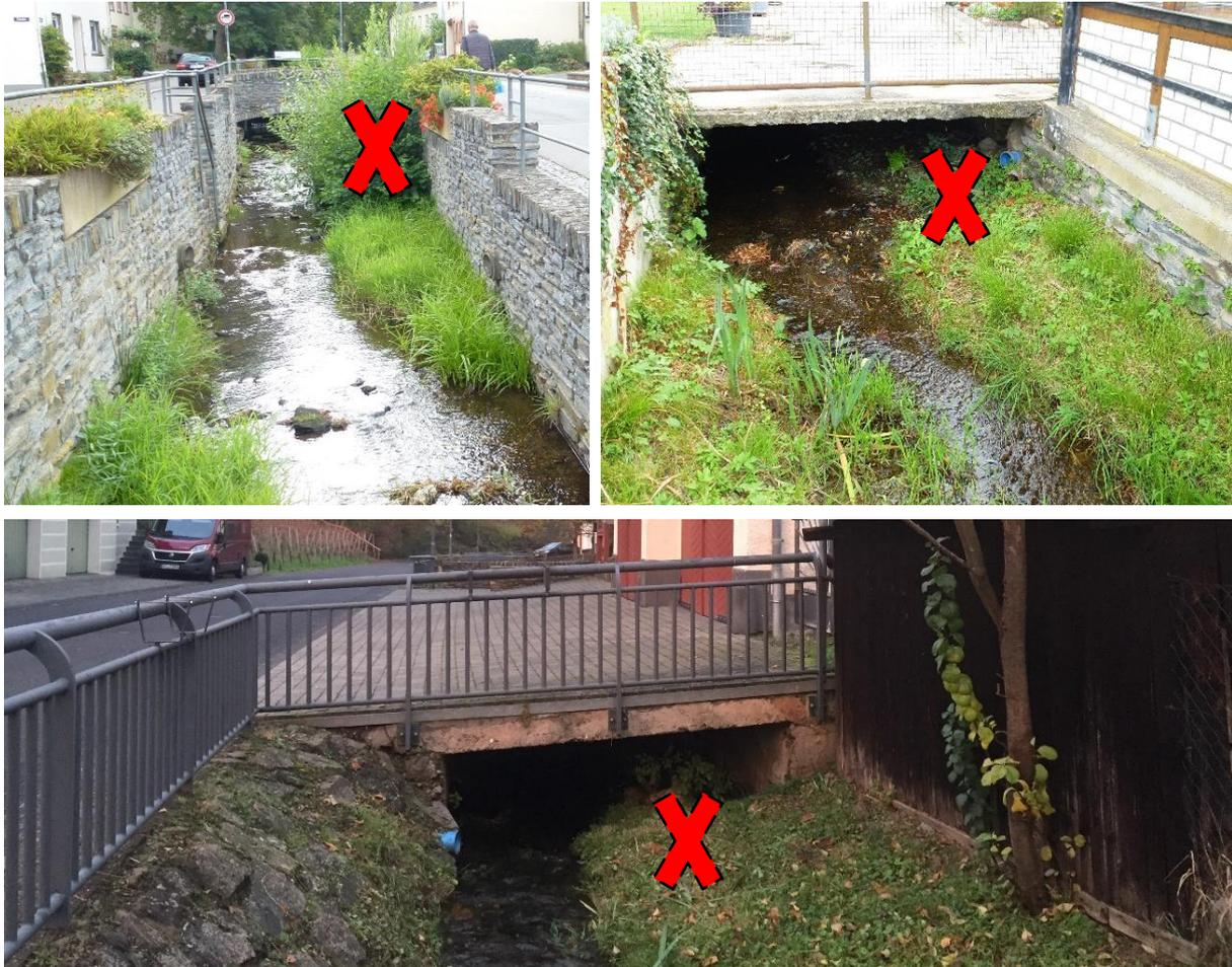
Abbildung 27: Fotos der zu entfernenden Anlandungen und Gehölze am Frohnbach und Waschgraben
